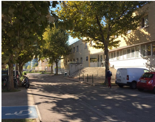
Un bâtiment de recherche : le M5
