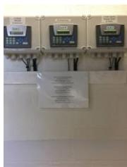
En intérieur, des appareils de détection de gaz assurent la sécurité des utilisateurs (Ex : détecteurs à anoxie avec alarme visuelle et sonore.)
