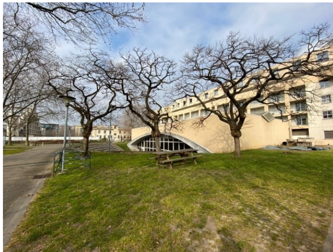
Figure 11 : Photographie du gymnase semi-enterré
