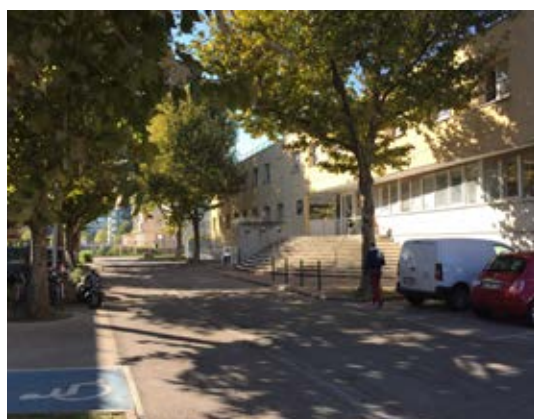
Un bâtiment de recherche : le M5
